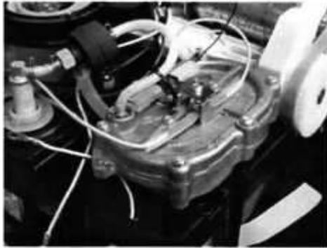
Chaudière avec thermo fusible et sonde de température
